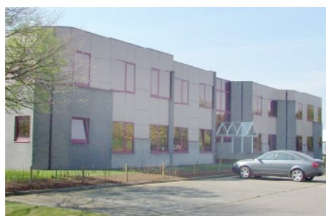
Nieuwland Aarschot Gebouw PVG A-01
